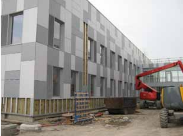
Fixation du parement de façade des nouveaux bâtiments après pose de l'isolant par l'extérieur.
