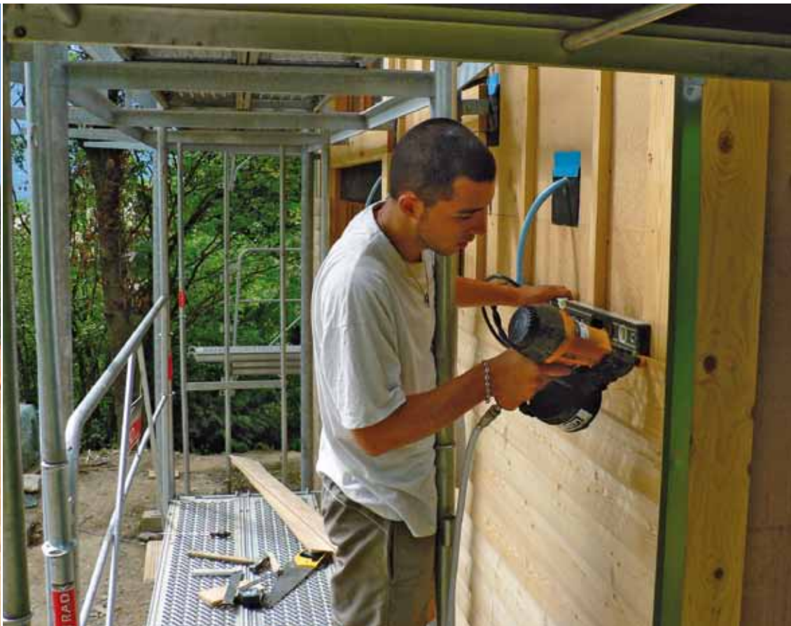
Une fois les murs doublés par l'extérieur avec 6 cm de fibre de bois rigide, ils sont habillés d'un bardage.
